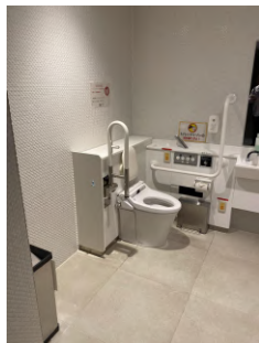
1階正面入り口右側の車椅子対応トイレ
